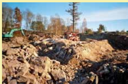
Felsensprengung, um einen Stall zu bauen
