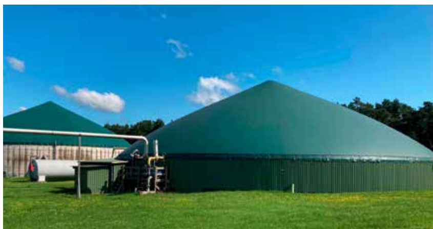
Für den Einsatz in der Biogasanlage eignet sich Sorghum hervorragend.
